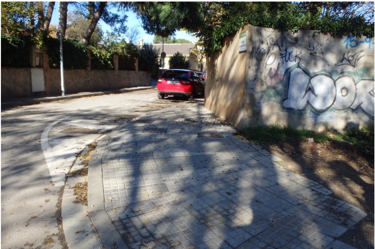
Fotografia 10. Arqueta aigua a resituar.
