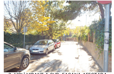
2. MOLI MIRANT A SUD, FAÇANA AFECTADA
