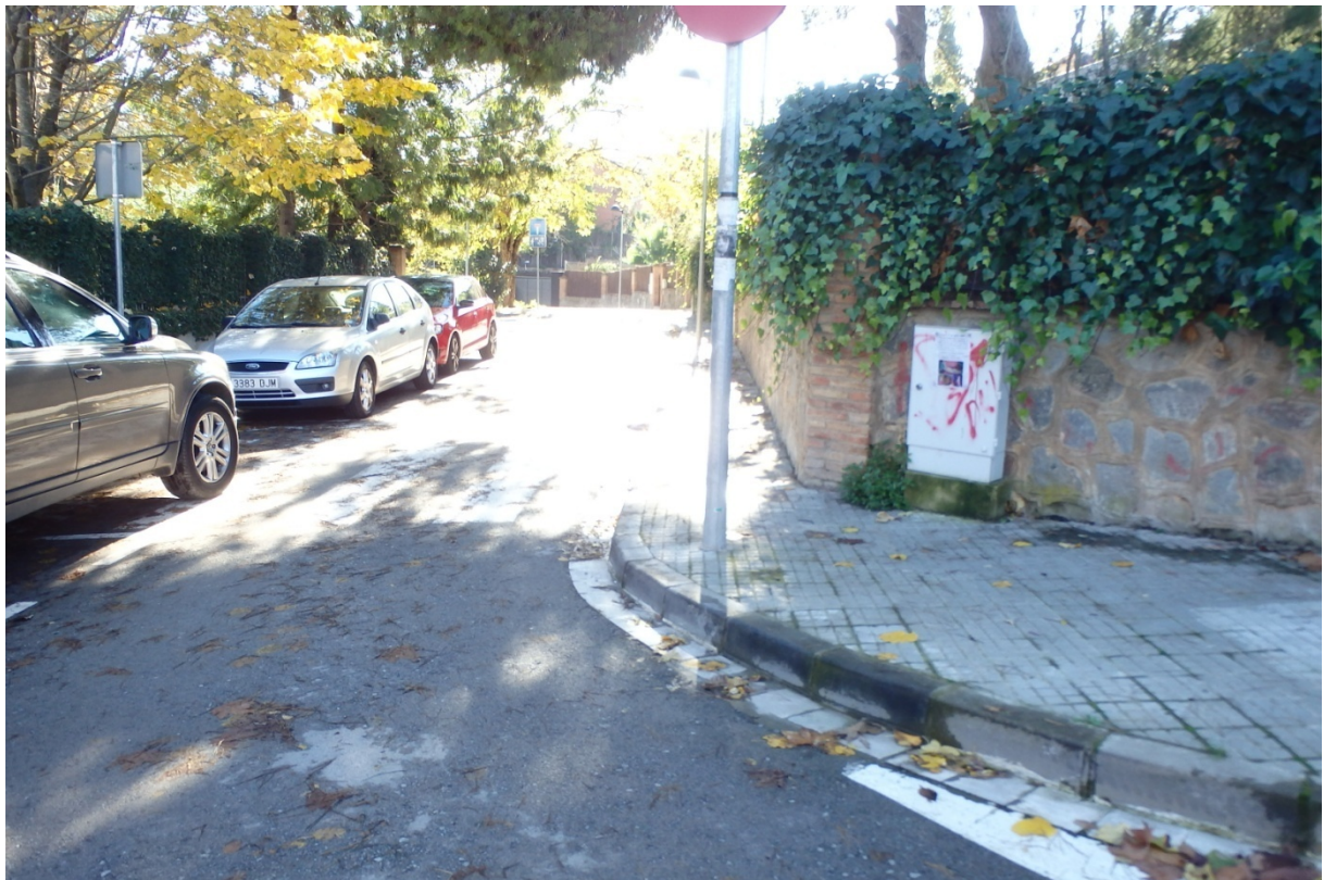
Fotografia 8. Detall armari afectat xamfrà N.O.
