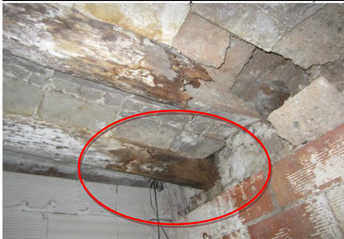
Biga 1n. Atac d'anòbid, de cerambícid i de fong de podridura tova. Tota la biga està afectada per la podridura. Es recomana substitució de la biga o substitució de la part afectada i reforç de la biga.
